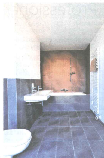
Eines der drei Bäder, die jeweils an die Schlafräume grenzen
